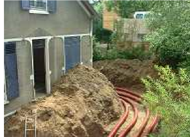
Enfouissement des gaines
