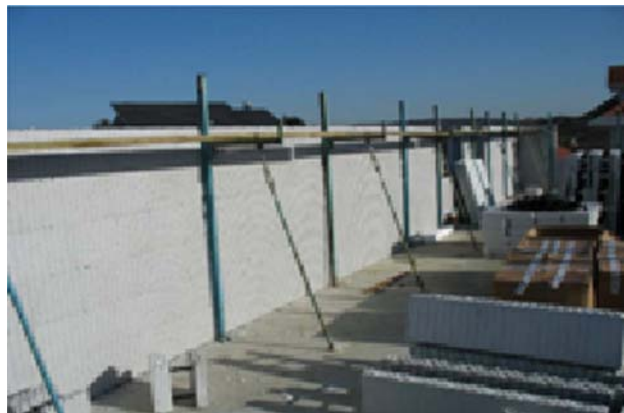
Étaieiment des blocs coffrant
