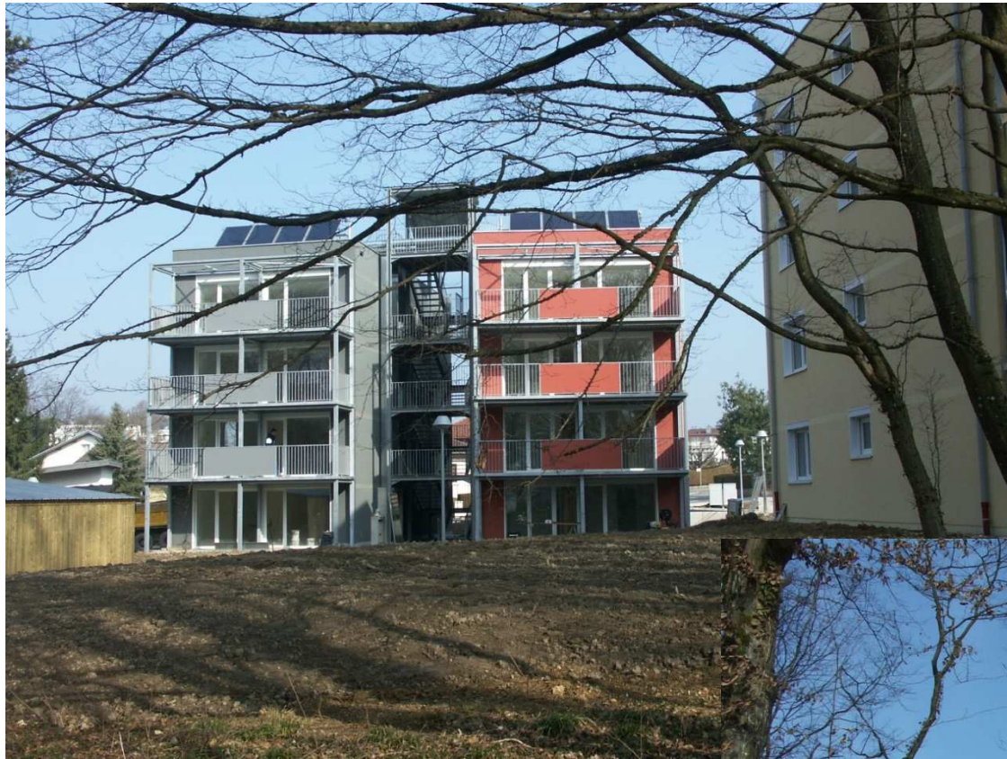
Idéha construction de 16 logements BBC Grand-Charmont (25)
